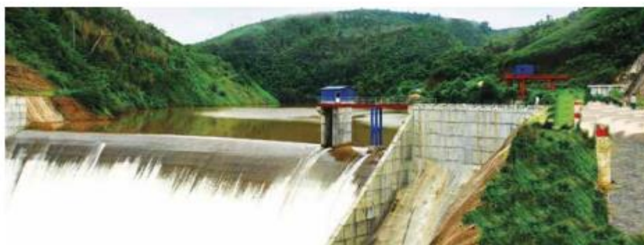
Nhà máy Thủy điện Đăk’r’ih
