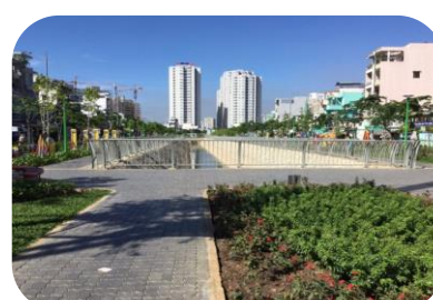
Cải tạo hệ thống nước (Gói K)
