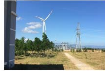
NHÀ MÁY ĐIỆN GIÓ BÌNH THUẬN
