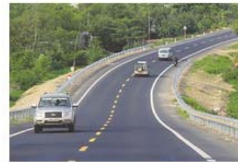
ĐƯỜNG HỒ CHÍ MINH ĐOẠN LA SƠN - TÚY LOAN (KM41 ĐẾN KM57)
