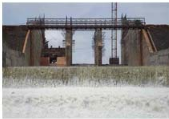
NHÀ MÁY THỦY ĐIỆN ĐÀKR' TIH
