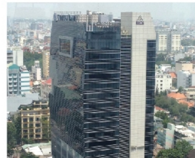
Tòa nhà HMTC 138-142 Hai Bà Trưng Địa điểm: Tp. Hồ Chí Minh Tiến độ thực hiện: 2010-2012
