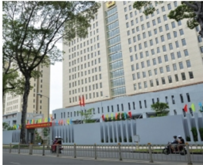
Trụ Sở Công An Tp. Hồ Chí Minh Địa điểm: Tp. Hồ Chí Minh Tiến độ thực hiện: 2013-2015
