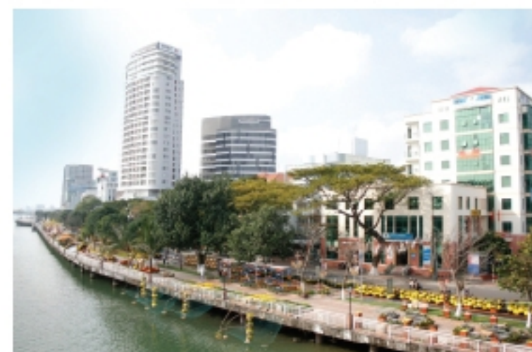
Nâng cấp, mở rộng đường Bạch Đằng Địa điểm: Tp. Đà Nẵng Tiến độ thực hiện: 2003 - 2004
