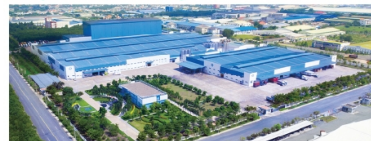
Nhà máy Sữa Vinamilk, Tỉnh Bình Dương, Tiến độ thực hiện: 2011 - 2013
