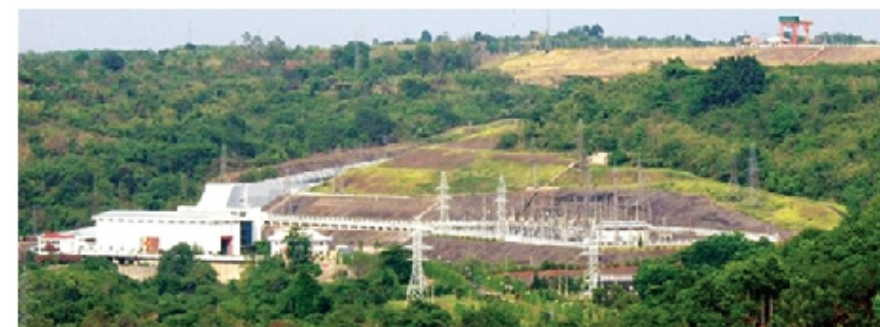
Nhà máy Thủy điện Thác Mơ (150MW) tỉnh Bình Phước do Bộ Năng Lượng đầu tư, hoàn thành năm 1995
