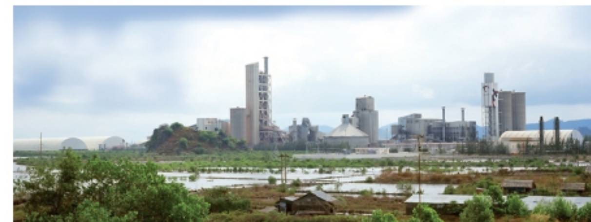
Nhà máy xi măng Sao Mai (Holcim), Tỉnh Kiên Giang, Tiến độ thực hiện: 1995 – 1998
