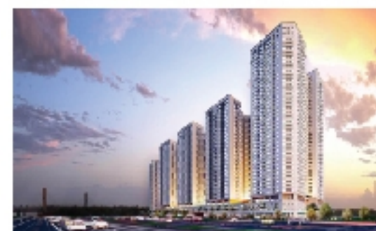
Nhà ở cao tầng thuộc dự án XD Khu nhà ở thuộc Khu tái định cư Đông Hội Địa điểm: Hà Nội Tiến độ thực hiện: 2017-2020
