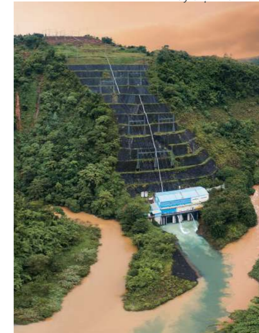
Thủy điện Đak R'Tih
